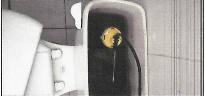
Foto 2: colocación de accesorios nuevos en los depósitos del sanitario.
