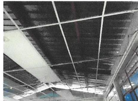
Foto 6: retiro de cielo falso en salón de clases.
