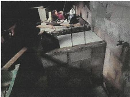
Foto 5: sustitución de polletón por estar en mal estado.
